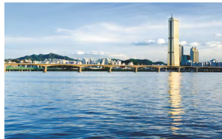
La Hangang (de Séoul)
