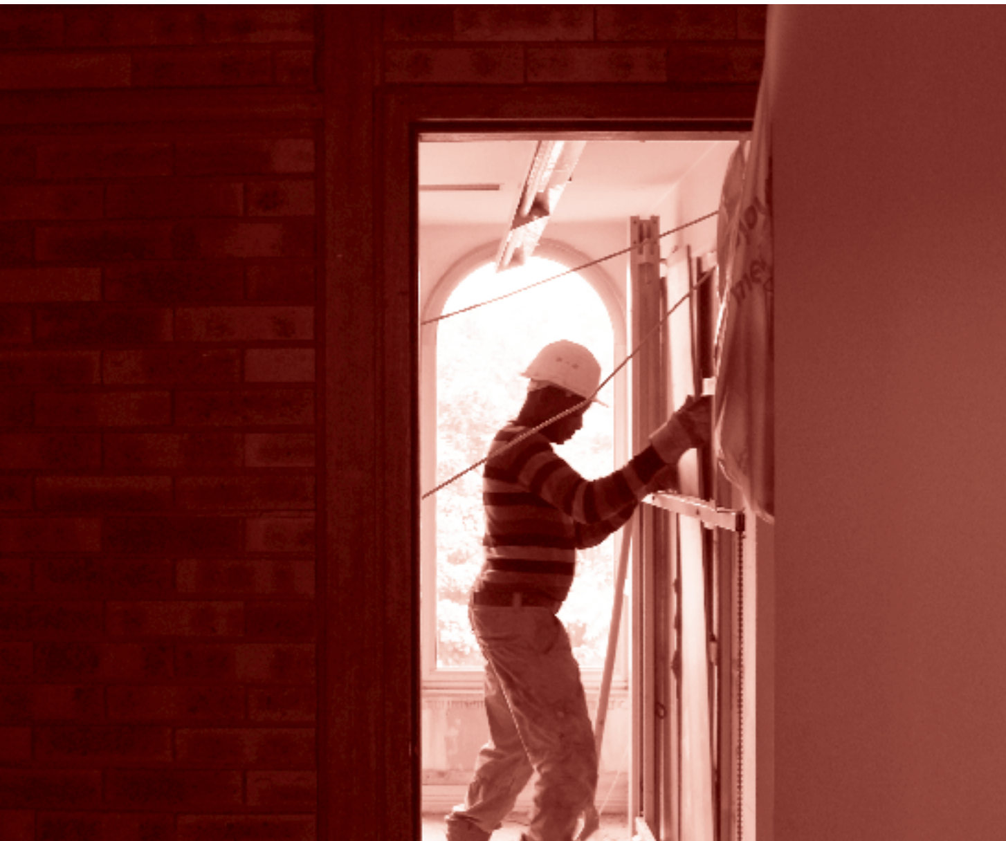
• les travaux de l'été 2013 (photo: P.-A. Colodiet)
